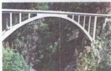
Von dieser Stahlbetonbrücke wagte auch so mancher Besucher aus Marktredwitz schon den freien Fall in die 103 Meter tiefe Drac-Schlucht. Foto: gs
